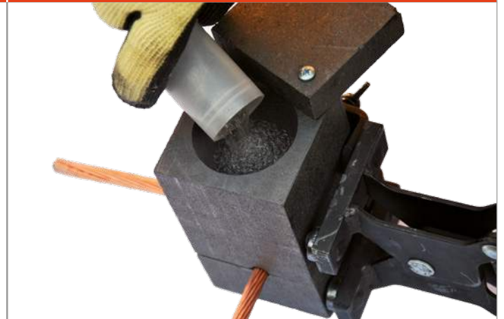
Verter el polvo de soldadura del cartucho abriendo la tapa blanca del mismo en el interior del crisol.
