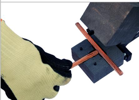
Colocar los conductores en el molde y cerrarlo.
