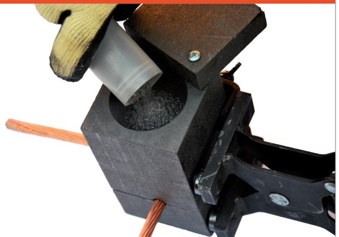
Verter el polvo de soldadura del cartucho abriendo la tapa blanca del mismo en el interior del crisol.
