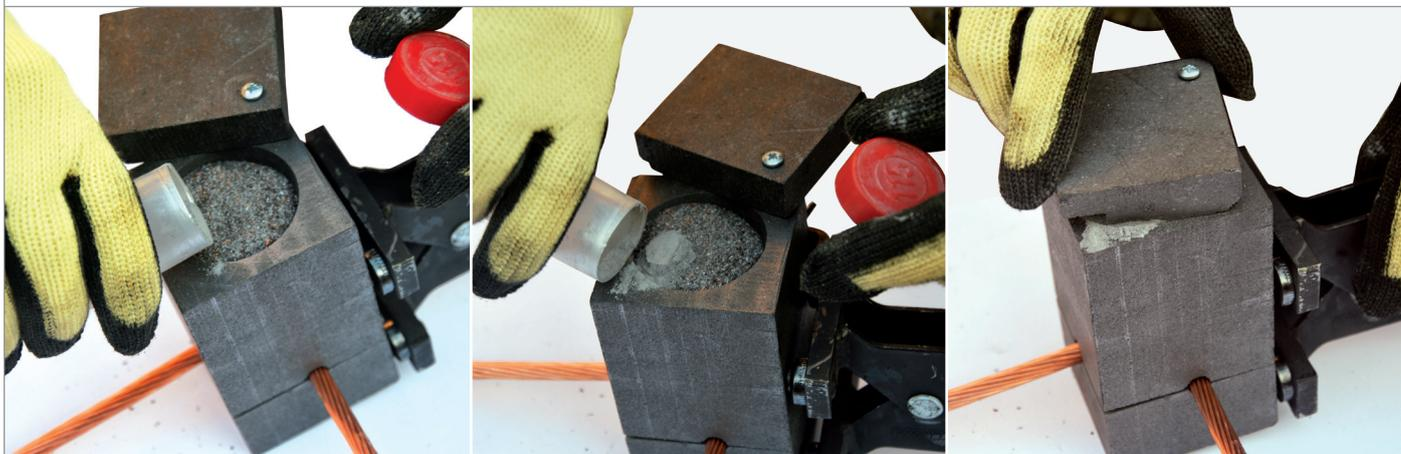
Verter gran parte del polvo de ignición encima del polvo de soldadura.
